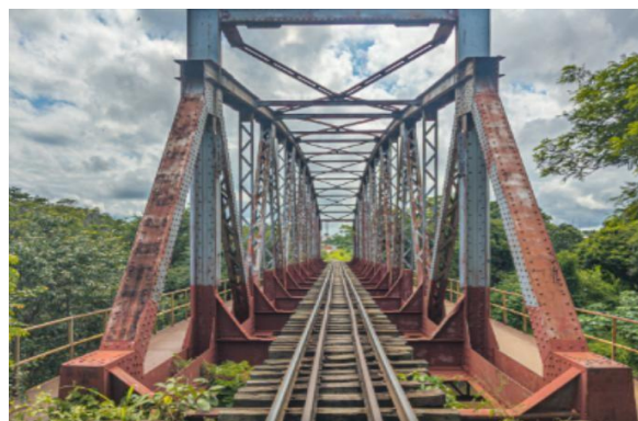
Figura 1: Ponte Metálica Benedito Leite, Caxias-MA
